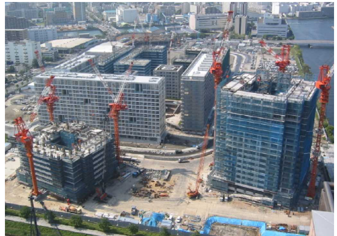
UR都市机构 東云CODAN CANAL COURT (部分PC工法)
